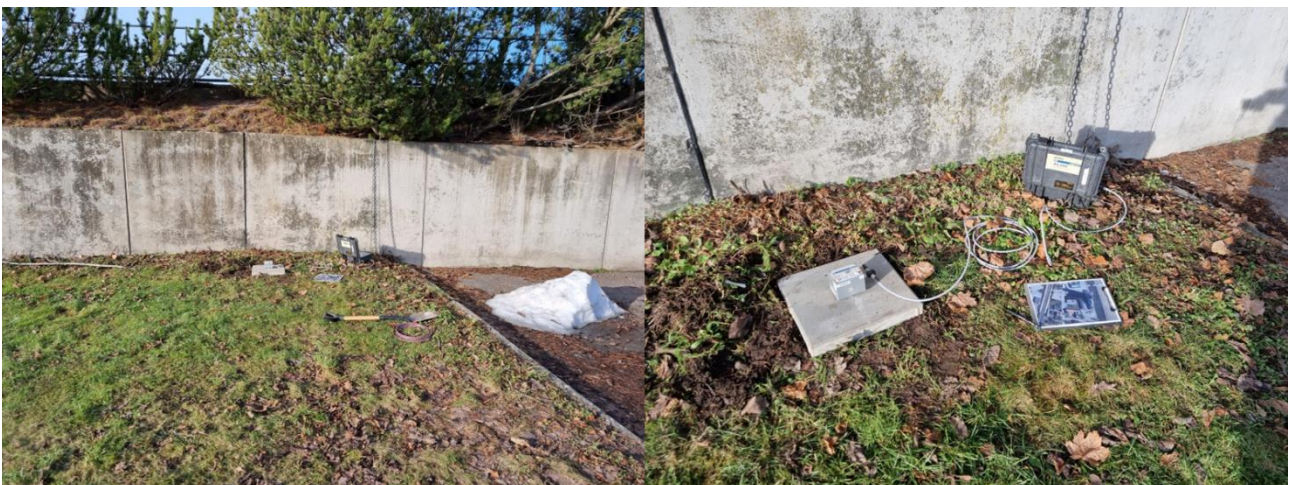
FIGUR 4: MÄTPUNKT 1, REFERENSPUNKT CA 10M FRÅN SPÅR.
