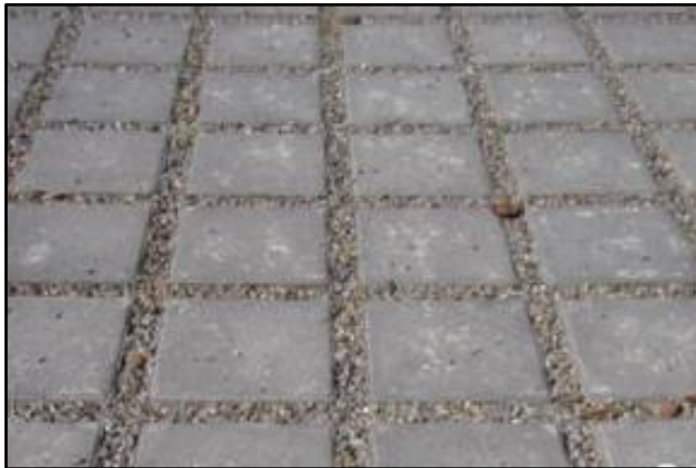
Figur 13. Exempel på genomsläpplig betongbeläggning med grusfogar.
