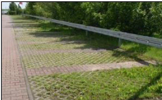
Figur 14. Exempel på genomsläpplig betongbeläggning med gräs.
