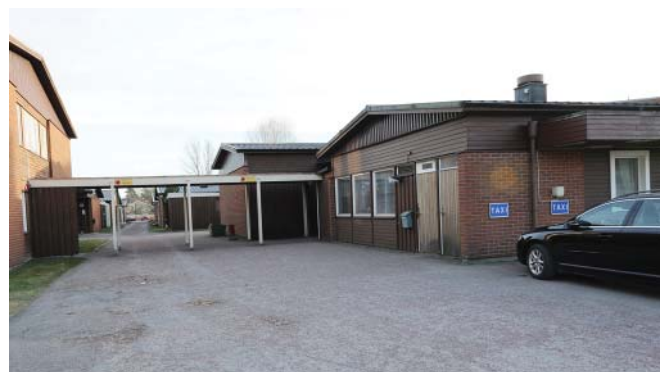
Gemensamhetslokalen i områdets sydvästra del
