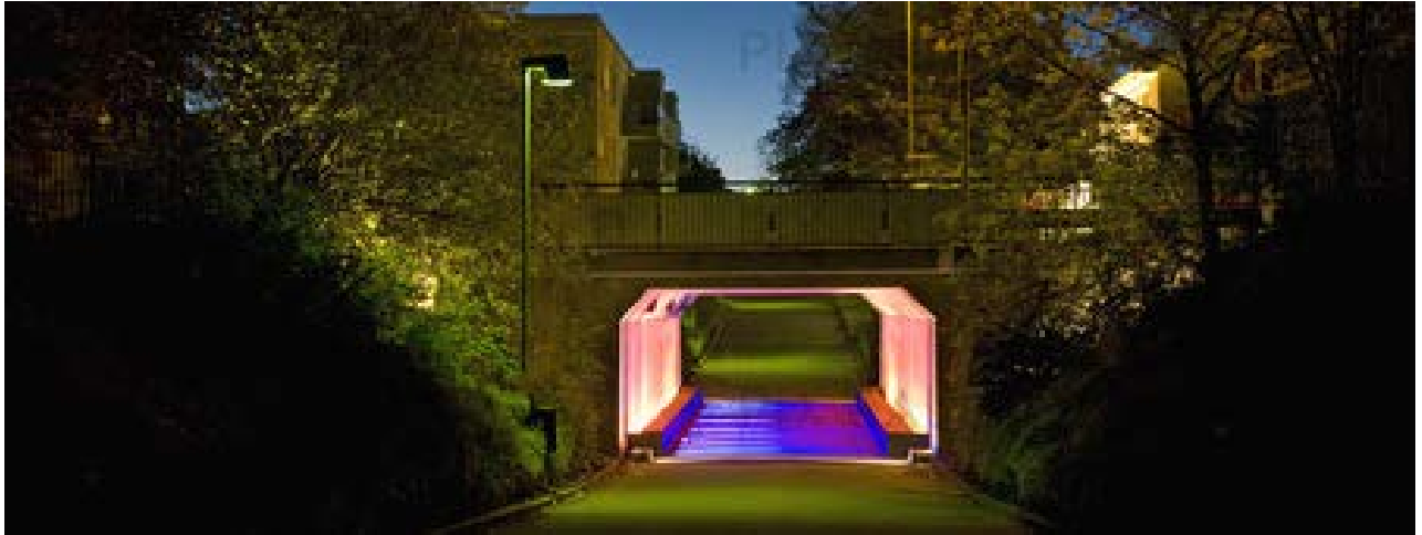
Exempel på belyst gångtunnel.
