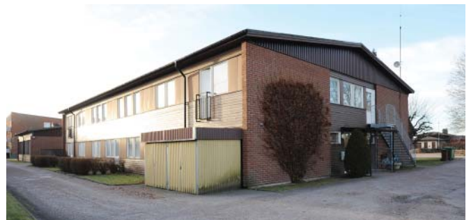
Tvåvåningshuset sett från nordost
