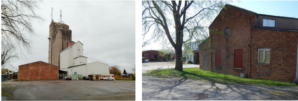
Figur 7: Silobebyggelsen till vänster och en lagerbyggnad (före detta gjuteri) till höger.
