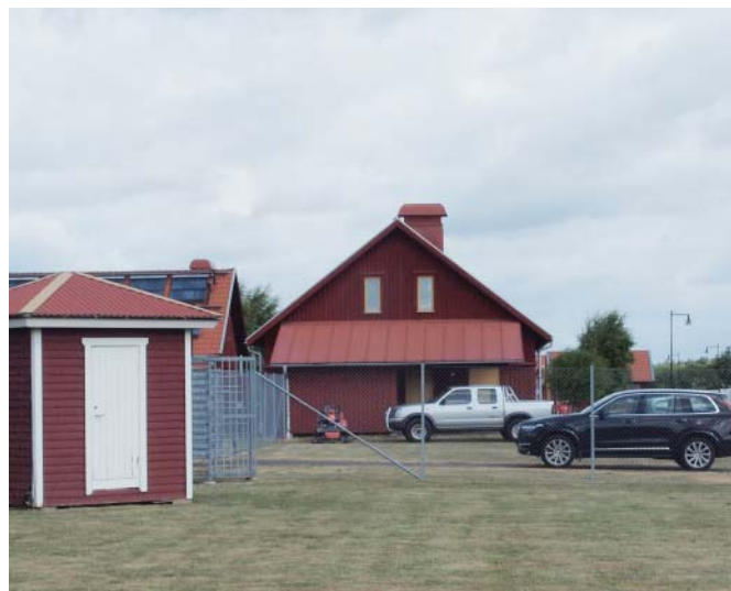
De södra husen uppförs intill den östra servicebyggnaden
