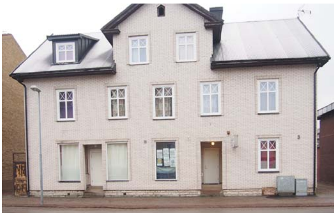
Bef. byggnad, fasad mot Östra Torggatan
