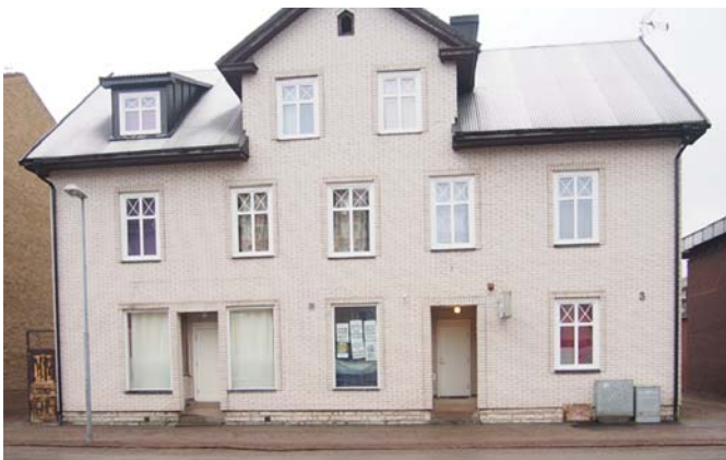
Bef. byggnad, fasad mot Östra Torggatan
